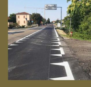
segnaletica verticale esistente con la sostituzione dei cartelli deteriorati e la ripassatura della segnaletica orizzontale, l'intervento è stato completato da un sistema di segnalazione e illuminazione a led degli attraversamenti pedonali e due dissuasori a radar, per segnalare il superamento del limiti di velocità. Positivi i primi commenti dei cittadini e soddisfazione da parte di tecnici e Amministrazione.
