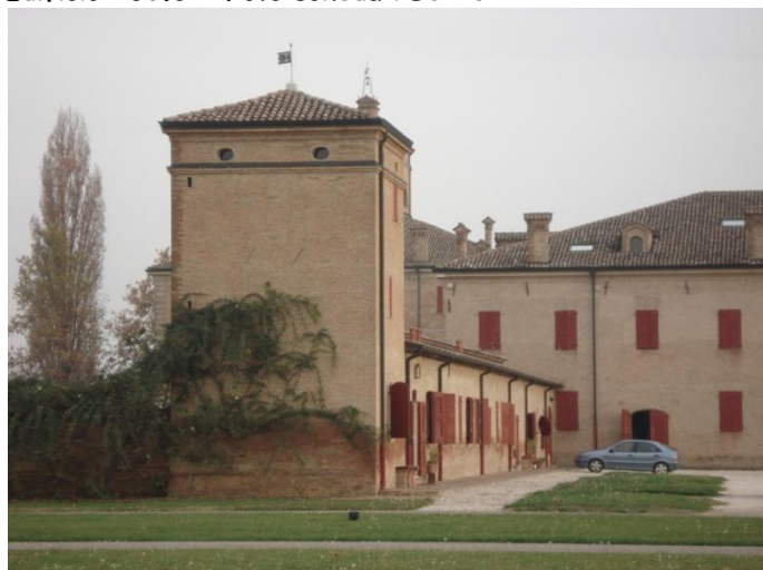
Edificio 230.c - Foto scheda PSC 2011
