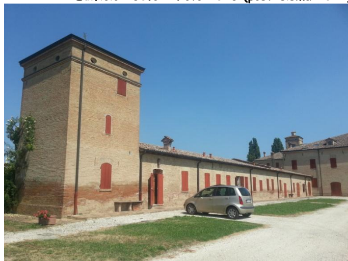
Edificio 230.c - Foto 2013 (post-sisma 2012)
