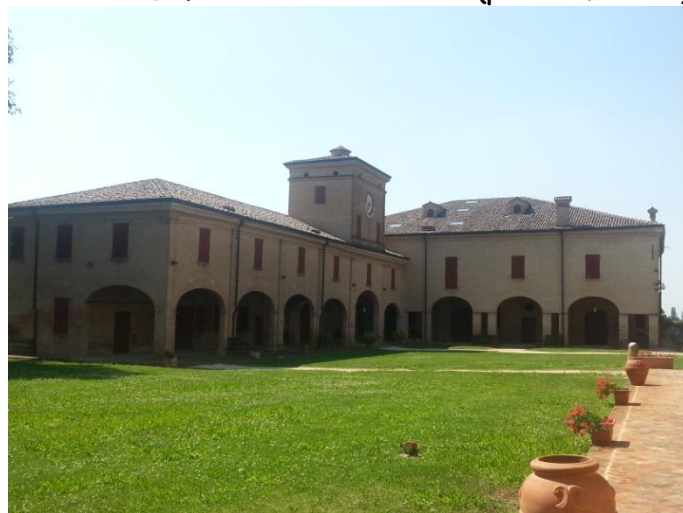
Edificio 230.c - Foto 2013 (post-sisma 2012)
