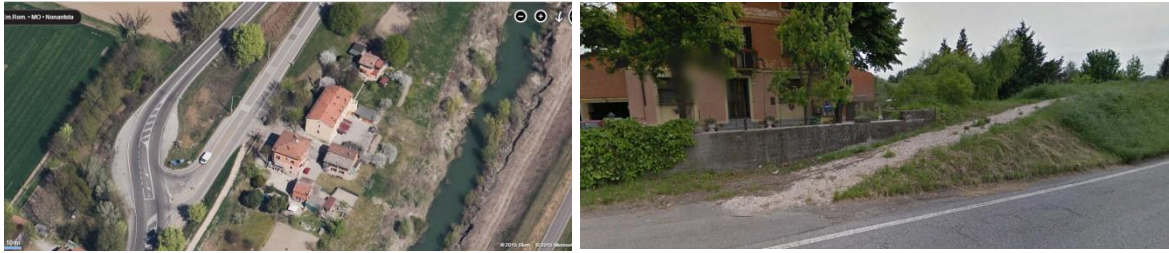
Figura 5-25 – Varco arginale in località Navicello.
