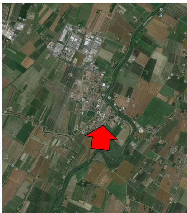
Figura 5-3 –Posizione della rotta in sinistra idraulica sul fiume Panaro, in corrispondenza dell'abitato di Bomporto
