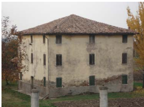
Casa colonica d'impianto ottocentesco. Copertura a quattro falde.
