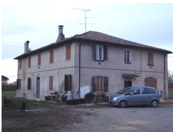
Casa colonica con annessa rimessa per cavalli.
