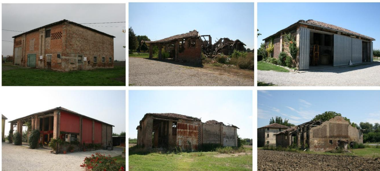
Le stesse costruzioni rurali dopo il sisma 2012
